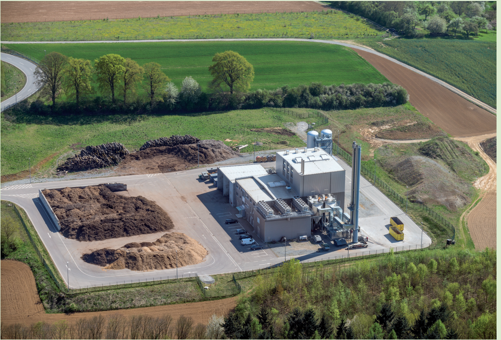
Das bestehende Biomasseheizkraftwerk als Wärmelieferant
